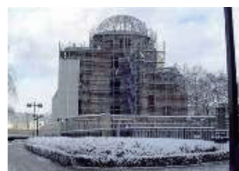
原爆ドームでの耐震工事
